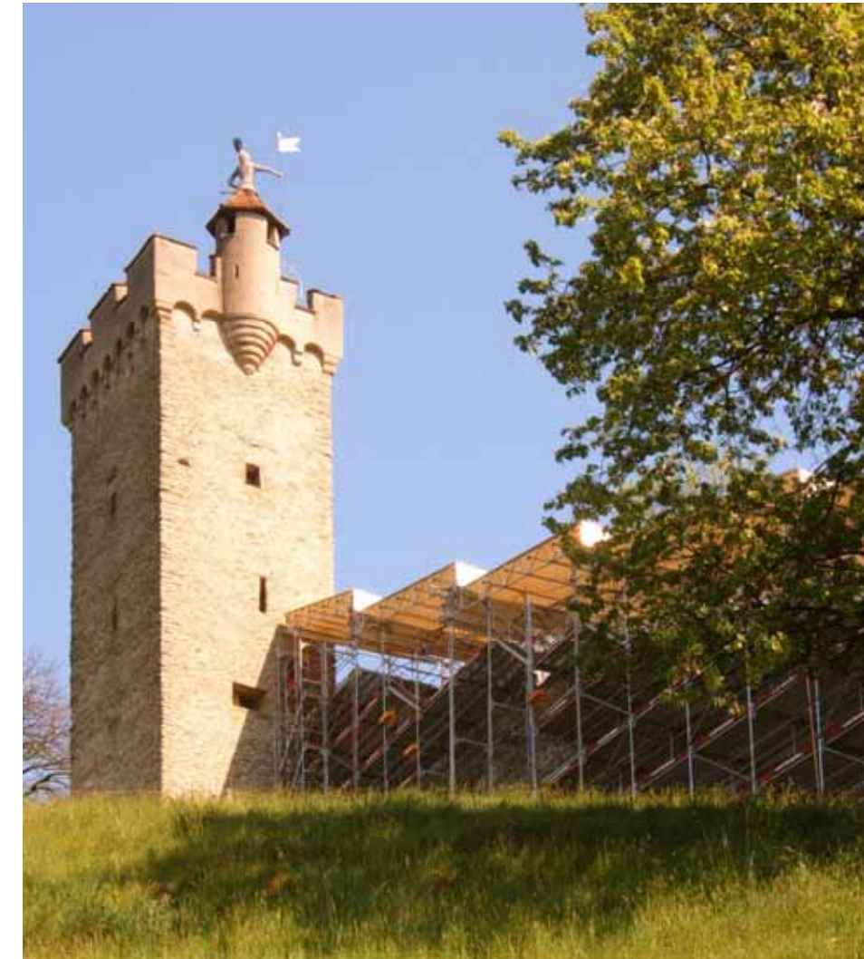
Restaurierungsarbeiten an der Museggmauer
