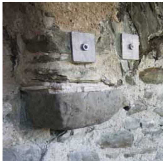
Neuer Konsolenstein mit Ankerplatte Bild Barbara Vogt, Arch.-Büro I. Bühler
