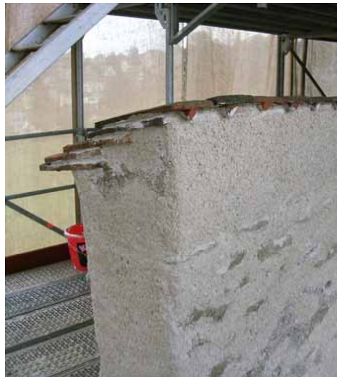
Zinne nach der Sanierung
