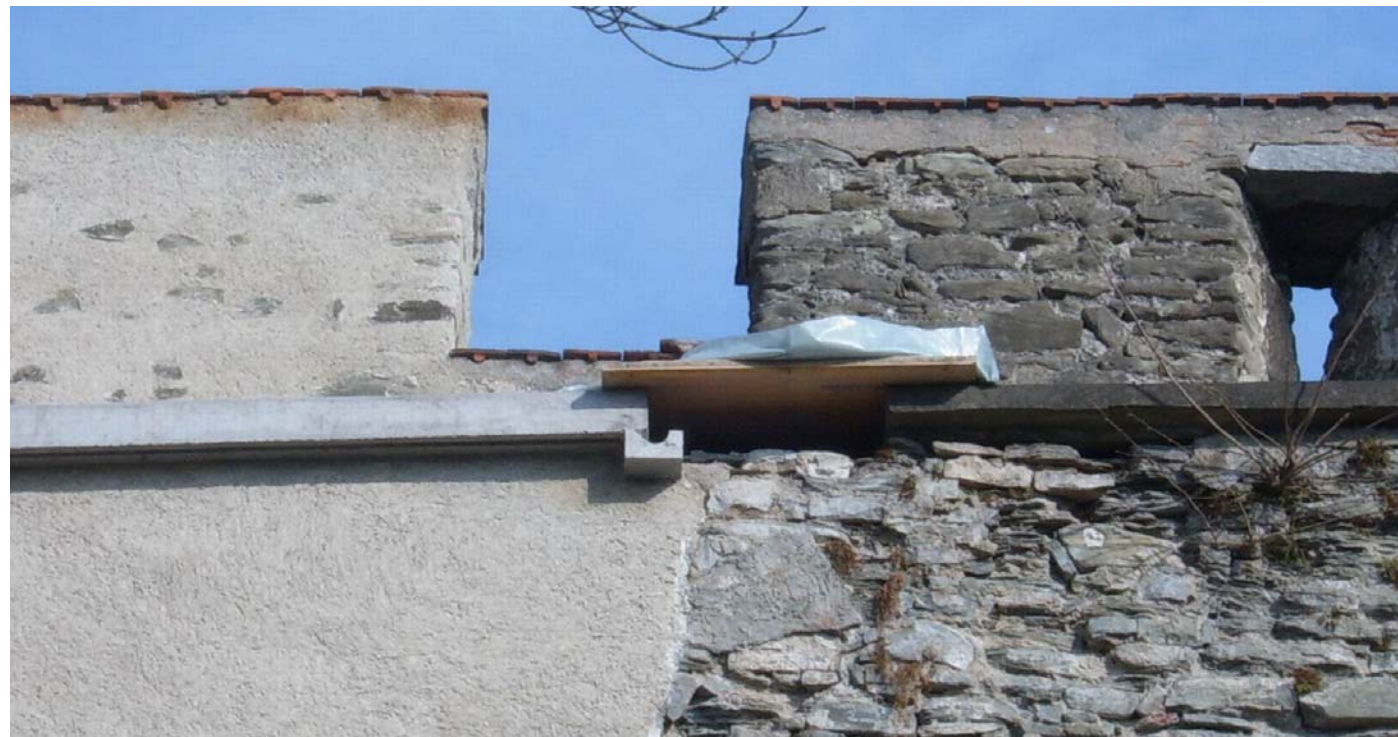
Zinne nach der Sanierung
